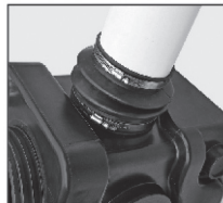
Рис. 10 Монтаж вентиляционного трубопровода
