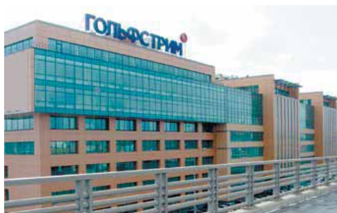
Офисный центр «Гольфстрим», г. Москва
