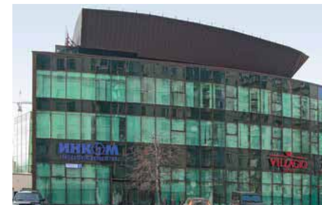
Офисный центр компании «ИНКОМ», г. Москва
