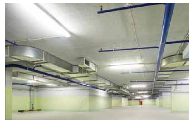
Подземная двухуровневая автостоянка, г. Королев
