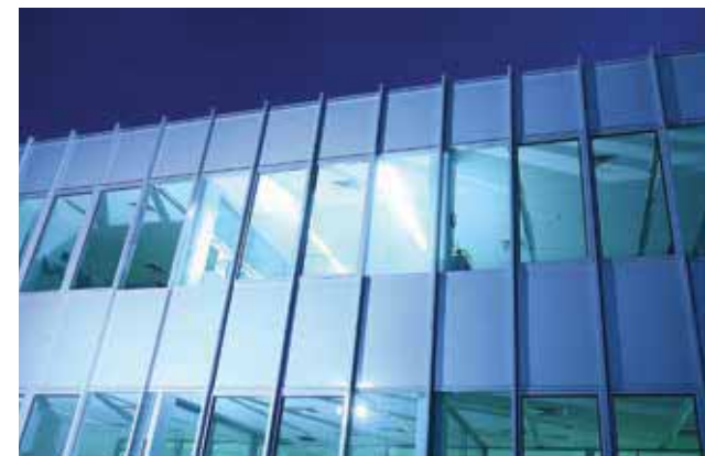
Офисно-производственно-складской комплекс, Московская область, г. Лобня
