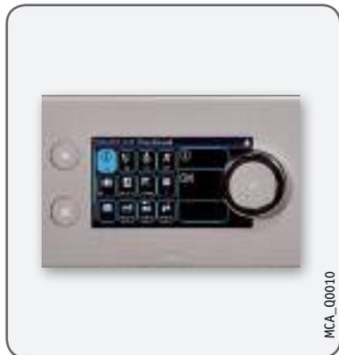
Панель управления Diematic Evolution — это самая современная панель с новой эргономикой управления. Она содержит погодозависимую электронную систему регулирования, которая воздействует на модулирующую горелку: температура воды в котле автоматически регулируется в зависимости от наружной температуры и даже от комнатной температуры, если подключено дополнительное оборудование — термостат комнатной температуры.
