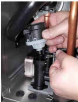
Подключите кабель клапана с электроприводом, как показано на рисунке.
