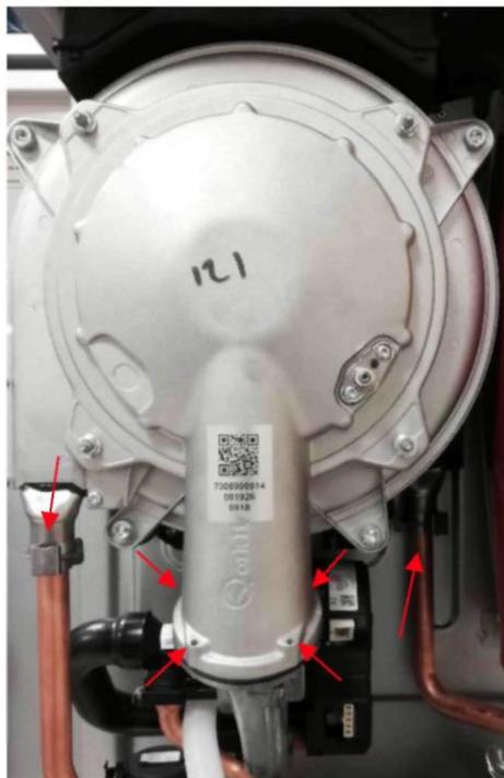
Снимите болты, соединяющие теплообменник с задней панелью.
