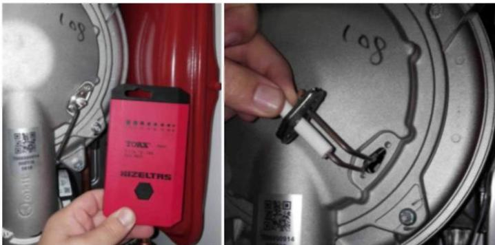
Снимите 4 болта крышки теплообменника. При снятии и установке крышки теплообменника выкрутите и затяните болты в перекрестном порядке.
