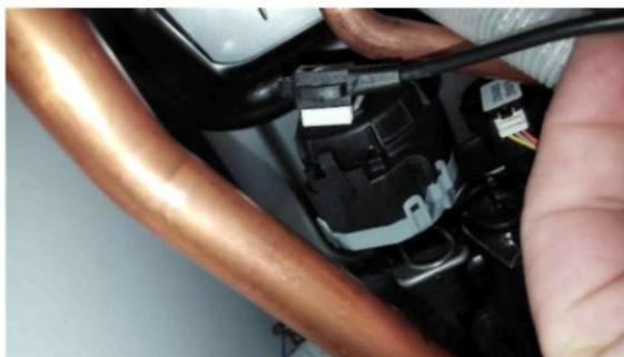
**Установка и снятие датчика напора воды:** Чтобы снять датчик давления воды, сифон должен быть полностью вытасчен. Затем отсоедините кабель датчика напора воды.
