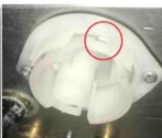
3- Перед сливом сифона отсоедините шланг для конденсата от входа сифона, чтобы убедиться, что проблема вызвана засорением. Визуально проверьте уровень воды. Убедившись, что сифон забит (если сифон наполнен водой до самого высокого уровня), снимите нижнюю часть корпуса сифона.
