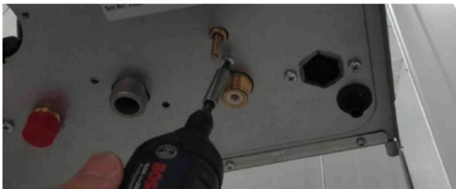
**Установка и снятие датчика потока:** Снимите зажим тонким ручным инструментом и снимите заглушку.
