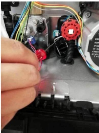
Снимите турбину и ограничитель потока с помощью тонкого ручного инструмента.
