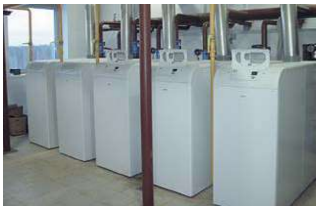
Кинотеатр, г. Йошка-Ола Общая мощность - 1,6 МВт
