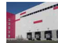
Распределительный центр Wildberries г. о. Подольск, МО
