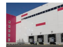
Распределительный центр Wildberries г. о. Подольск, МО
