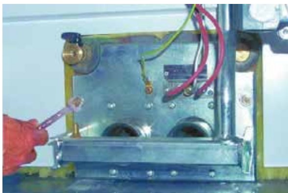
рис. 22 - Демонтаж горелок
