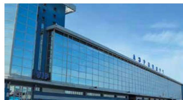
Международный аэропорт Иркутск г. Иркутск
